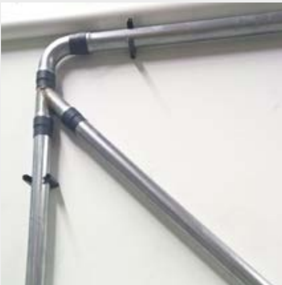
Figura 9: Soporte de montaje para tubo de acero con funda retráctil.
