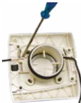
Figura 3: El circuito de arranque funciona a una tensión de aproximadamente 24V. El cable de baja tensión se conecta a cada toma de aspiración y a los conectores de la toma de cocina, si está instalada.
