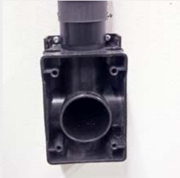
Figura 8: La toma de aspiración Clásica se fija a la tubería de acero con funda retráctil.
