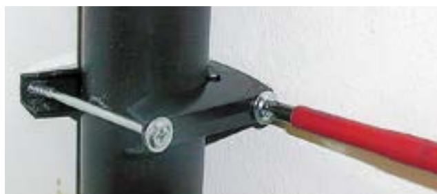
Figura 3: La abrazadera de tubo se puede instalar desde el lateral con tornillos largos para evitar que el tubo se deslice en la abrazadera, es decir, la abrazadera bloquea el tubo en su sitio.
