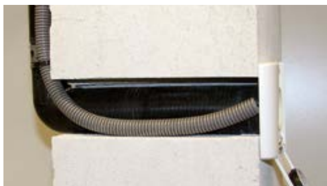
Figura 10: Cuando una tubería está conectada a la toma de aspiración en el otro lado de una pared de separación, se perfora un agujero con un diámetro de 50 mm a través de la pared para la instalación de la toma de aspiración. El acoplamiento del codo de la toma de aspiración se inserta en el extremo de la extensión. Si la toma de aspiración se instala a través de paredes gruesas, se pueden utilizar sucesivamente varias extensiones. La longitud de la extensión es de 13 cm. Las extensiones de la toma de aspiración se utilizan en instalaciones a través de paredes gruesas.
